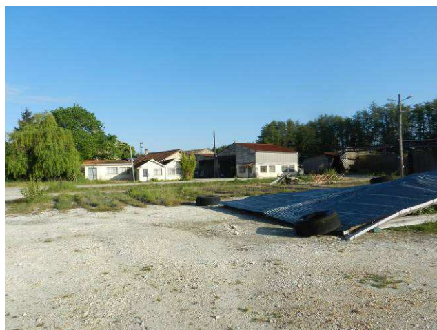
Bac de trempage dépollué (en arrière-plan) et bac de trempage avec abri effondré (au premier plan)
